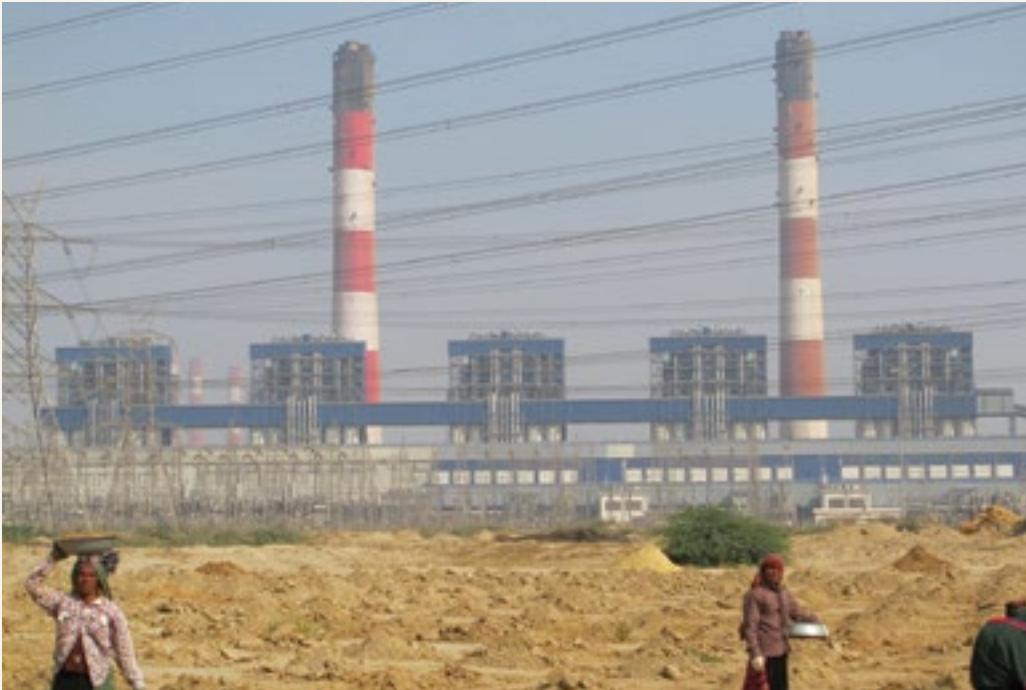
Proyecto de infraestructura en Asia Meridional.
